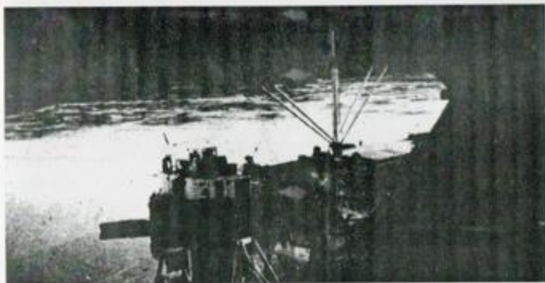
Embarcando la yerba en Pto. Esperanza. Mediante "canaletas" (planos inclinados) las bolsas de 60 kg de yerba canchada van directamente del depósito en la barraca a la bodega del buque. 1955
