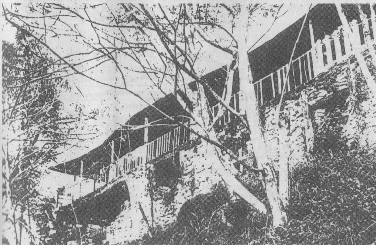
Vista lateral de "El Casino" (en demolición)
