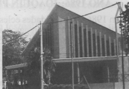
Edificio actual Catedral Nuestra Señora del Carmen -Interior y exterior
