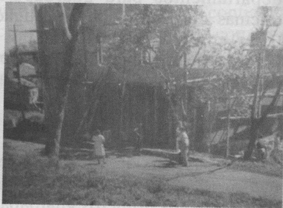
Edificio en construcción.
